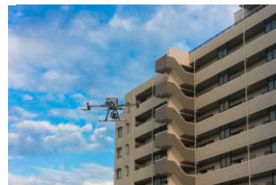
建物外壁点検
