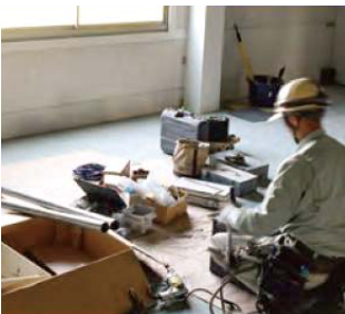
通電前の内装工事
